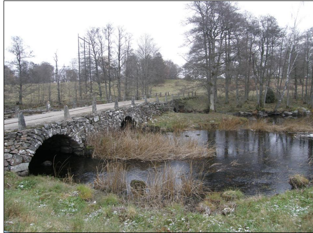
Fig. 7. Stenvalsbron vid Örsled från Sydsydväst. Foto från december 2016.
