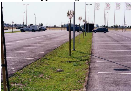
Exempel på anlagd infiltrationsyta på parkeringsplats.
