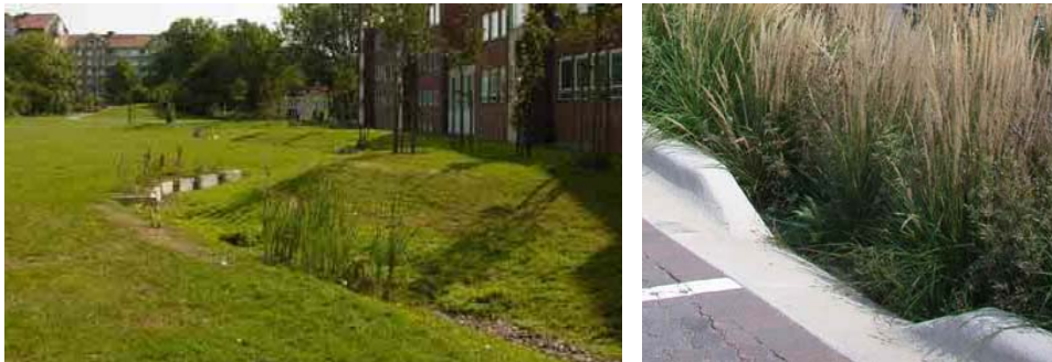
T.v: En anlagd meandrande "bäck" med erosionskydd i svängarna. Dessa förstärker här det slingrande formspråket. Augustenborg, Malmö. Bild: Stahre (2008, s. 55).
