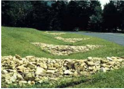
Exempel på fördämningar av sten. Bild: Yocum (2009-05-25, s. 3).
