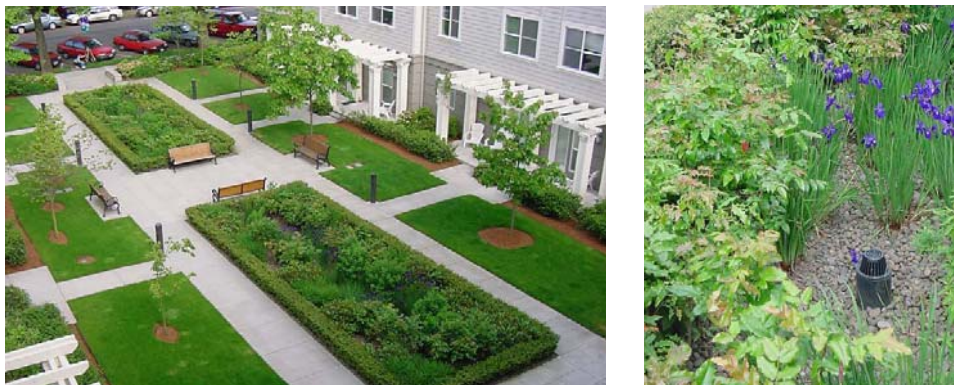
T.v: Exempel på infiltrationsplanteringar på Buckman Heights Apartments i Portland, Oregon. De två rektangulära infiltrationsplanteringarna i mitten tar hand om regnvattnet från taken och från de hårdgjorda ytorna på gården. T.h: Planteringsytan har försetts med ett breddavlopp. Bilder: Liptan och Murase (2000, s. 11).
