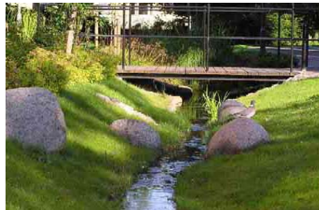
T.v: Betongkanalen som leder till en stilren damm med en fontän i mitten utgör ett uppskattat inslag på bostadsgården. Bild: Stahre (2008, s. 52). T.h: Ett svackdike som har utformats i en naturlig karaktär. Augustenborg, Malmö. Bild: Stahre (2008, s. 57).
