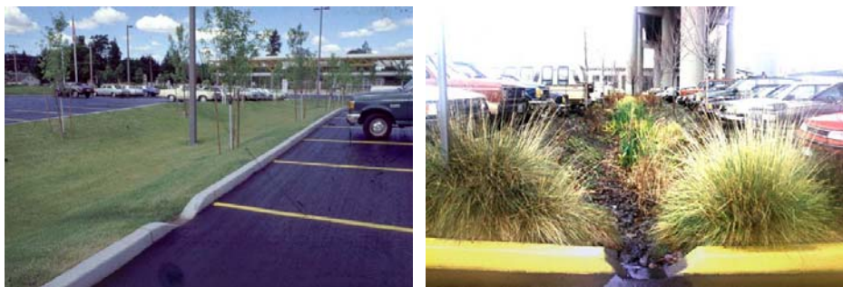
T.v: Ett biodike med klippt gräsmatta, vilket används i Sverige under namnet svackdike. T.h: Ett biodike med friväxande, tät vegetation, som används i USA och som har bättre fördröjnings- och reningsförmåga än det gräsbevuxna svackdiken. Bilder: Jurries (2003, s. 29-30).
